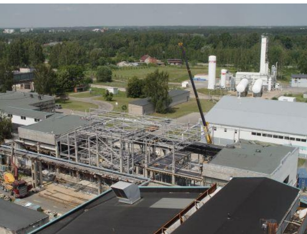
2012.gada jūlijs: nobeigta jumta metāla konstrukciju montāža
