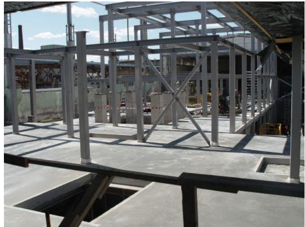
2012.gada jūnijs: iebetonēts starpstāvu pārsegums uz atzīmes +3.200
