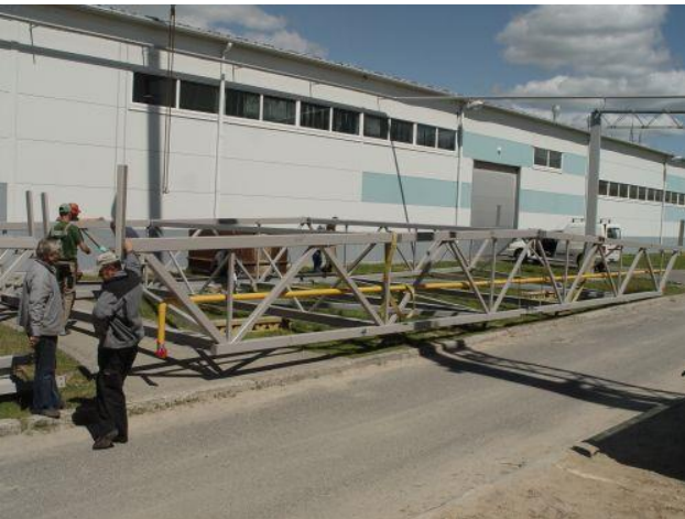
2012.gada jūnijs: galvenās jumta konstrukcijas pirms montāžas
