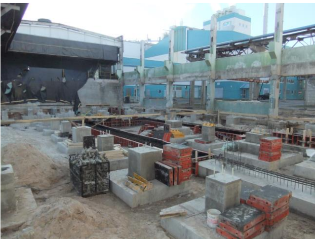
2012.gada marts: iekārtu pamatu izveide
