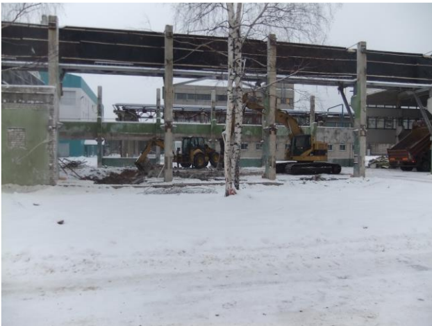
2012.gada janvāris: vecās ražošanas ēkas būvkonstrukciju demontāža
