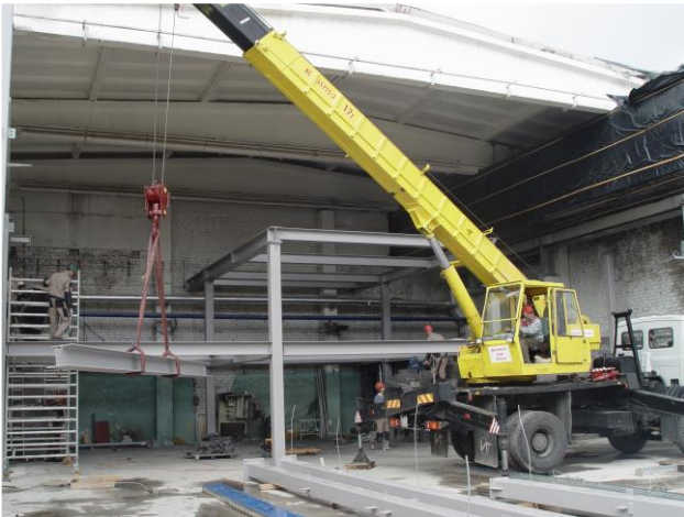
2012.gada maijs: metālkonstrukciju montāža
