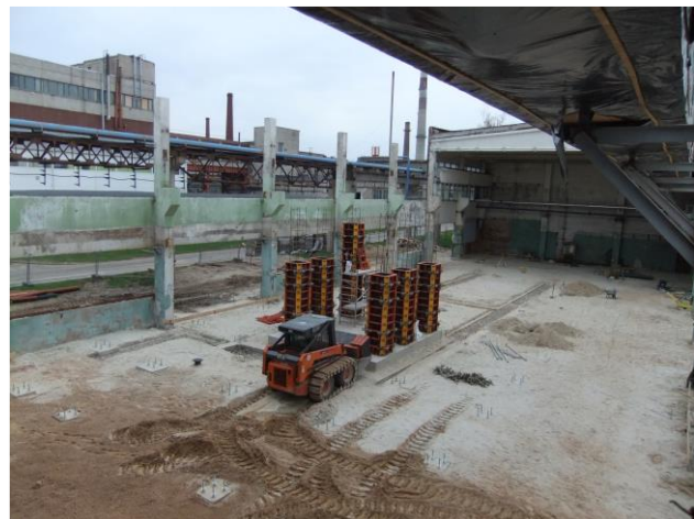
2012.gada aprīlis: stikla kausēšanas krāsns pamatizbūve
